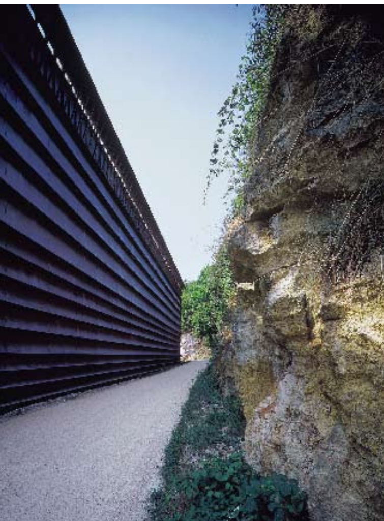
Opslaggebouw van Ricola in Basel, Zwitserland door Herzog & De Meuron. (Foto: Margherita Spiluttini)
